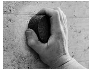
Fig. 2.1 Préparer la surface à examiner
