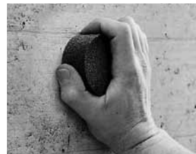
Fig. 2.1 Prüffläche vorbereiten
